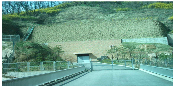
그림 4.1-1 터널식 배수지의 예(북악터널배수지)
