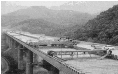
<LMC 교면포장 모습>
