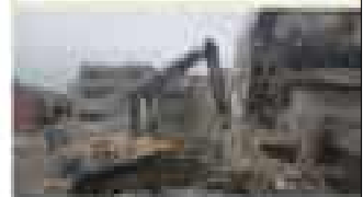
(외벽, 슬래브 해체)
