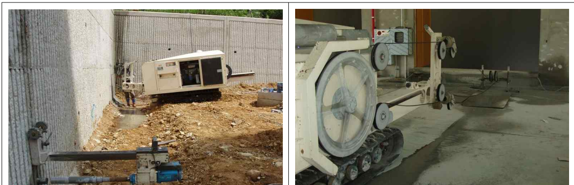
다이아몬드 와이어쏘우 작업
