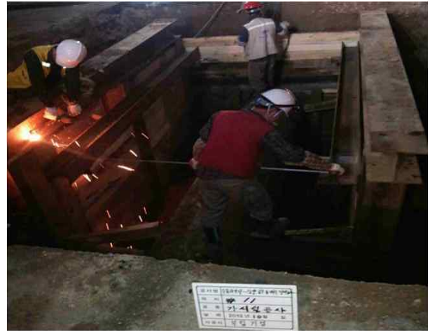
가시설 설치 중
