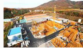
초평 공장 ▪ 타워크레인 제조 / 서비스 (21.7.1일자 한국타워크레인㈜ 합병)
