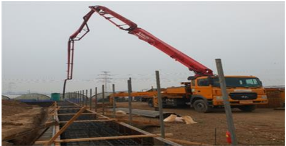
<그림13> 전진건설로봇의 콘크리트 펌프카
